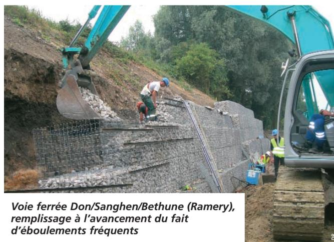
**Voie ferrée Don/Sanghen/Bethune (Ramery), remplissage à l'avancement du fait d'éboulements fréquents**
