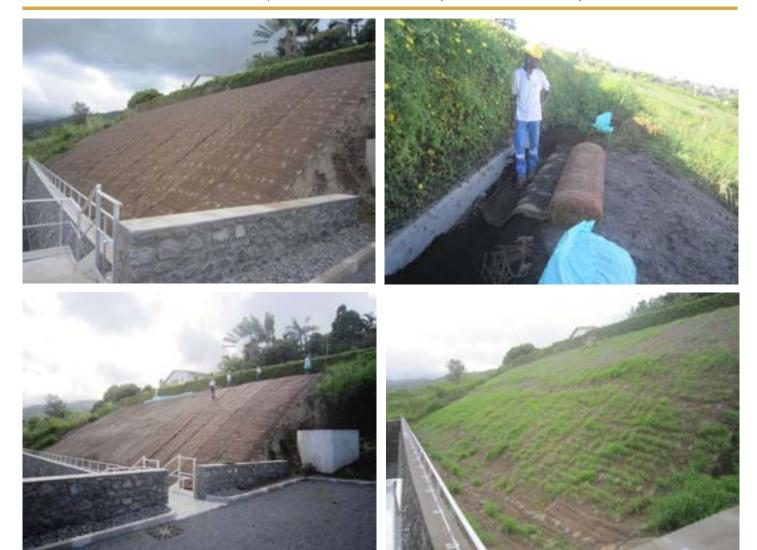
L'enherbement a particulièrement bien fonctionné malgré la date tardive et les très fortes pluies. Les tâches blanches ou jaunes sur la couverture NAG C350 indiquent l'emplacement des fixations et permettent un gain de temps important et apportent plus de sécurité à la pose.
