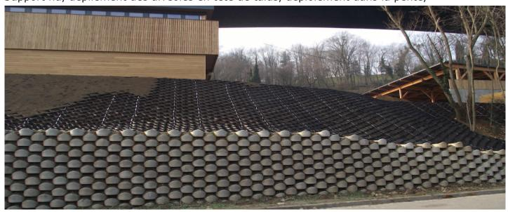
fixation sur le support par câbles et piquets
