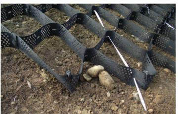
Support nu, dépliement des alvéoles en tête de talus, déploiement dans la pente,
